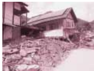
土石流にのみこまれた家屋
